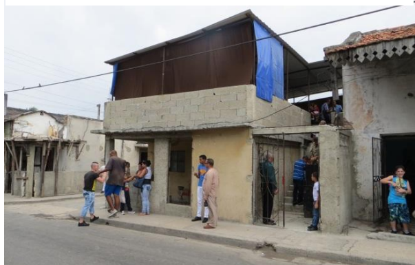
Laje de concreto com telhado de chapa, o ponto de encontro da igreja em Zaldo
